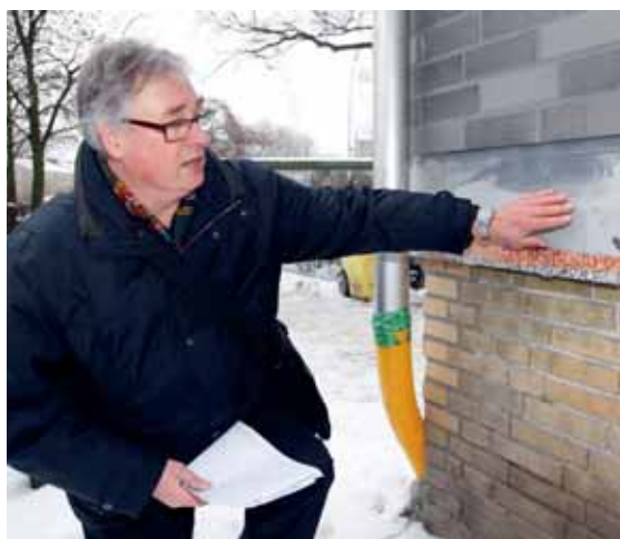
Projektleiter Johannsen zeigt das neue Wärmedämmverbundsystem in Flachklinkeroptik
