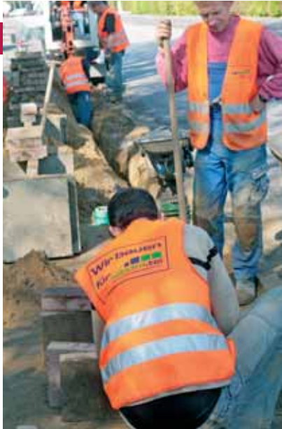
Bauarbeiter-Kolonnen lassen die Schutzrohre für die Glasfaserleitungen vor den Häusern im Gehweg-Bereich etwa 60 Zentimeter tief in die Erde ein
