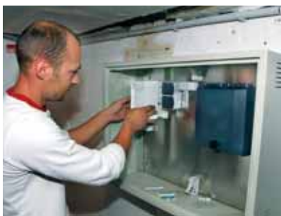
Die Innenverkabelung: Marco John montiert im Keller einen Schaltschrank für den Strom-Umverteiler, den Antennenverstärker sowie die Spleiß-Box
