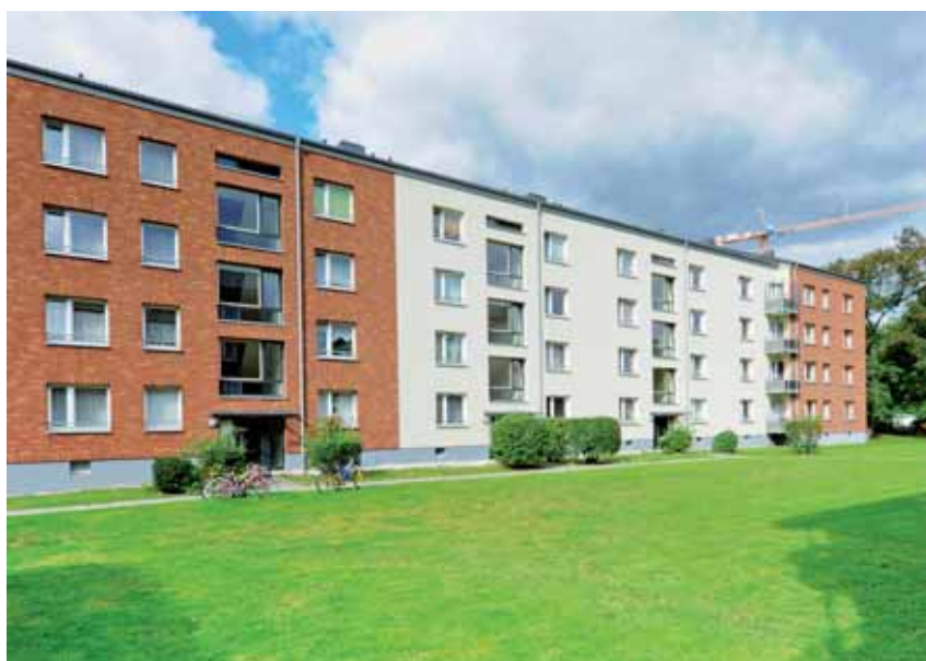
Einige Gebäude in Wandsbek sind bereits fertig gestellt
