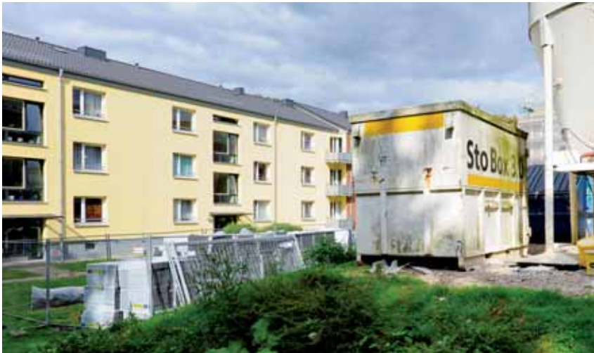
Die Fassadenmodernisierungen sind fast komplett abgeschlossen
