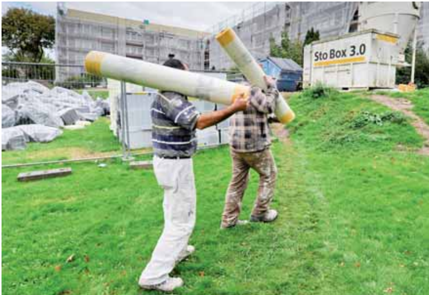
Voraussichtlich Ende nächsten Jahres soll die gesamte Wohnanlage fertig gestellt sein
