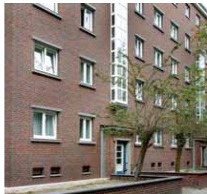
Die Hausfassaden nach der Modernisierung: Die traditionelle Rotklinkeroptik bleibt erhalten
