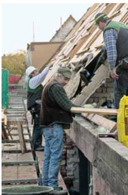
Neue Dächer mit moderner Wärmedämmung helfen, den Heizenergieverbrauch zu senken
